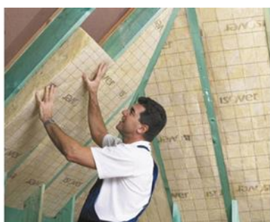
Plaatsing van dakisolatie met lambda-waarde 0,035 W/mK
