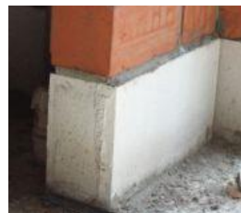
Aanzet binnenspouwblad op vloerplaat met Kimblok
