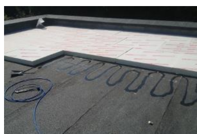
Plaatsing dak dakisolatie plat dak
