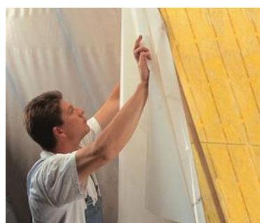
Aanbrengen van een dampscherm
